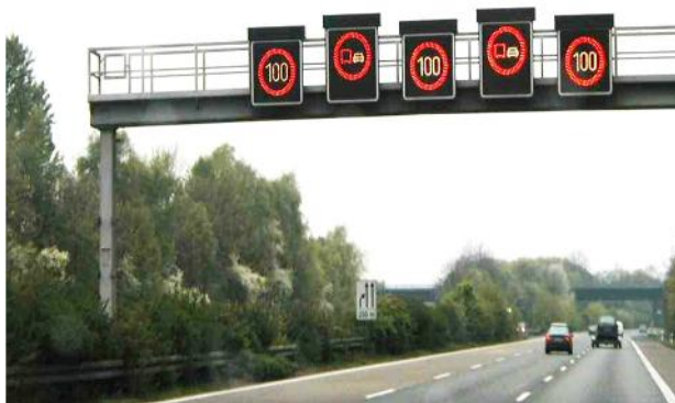
Slika 9 - Informisanje vozača pomoću VMS-a (Izvor: Vukanović S, (2014) "Inteligentni transportni sistemi u drumskom saobraćaju -osnove", Saobraćajni fakultet Beograd)
