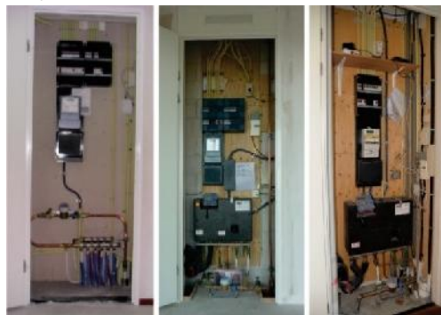
Slika 11 - Prostor za merne instrumente u stanu, merni ormar, tri primera. Izvor: li na arhiva autora rada
