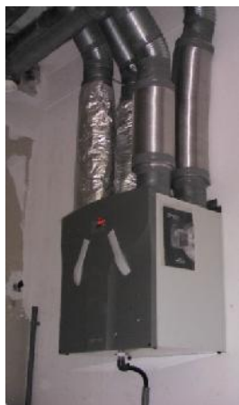
Slika 7 - Jedinica balansirano ventilacionog sistema (WTW unit). Izvor: li na arhiva autora rada
