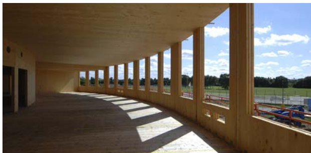
Слика 2. CLT конструкција школе у Норвичу УК
