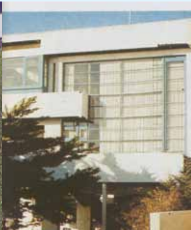
Сл.15. Рудолф Шиндлер: Кућа Лавел Бич, Балбоа Пенинсула, Калифорнија, 1926. Fig. 15. Rudolf Schindler: Lovell Beach House, Balboa Peninsula, California, 1926.
