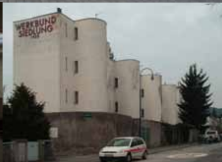
Сл. 12. Зграда Андреа Лурката, Беч, Аустрија, 1932. Fig. 12. Building by André Lurçat, Vienna, Austria, 1932.
