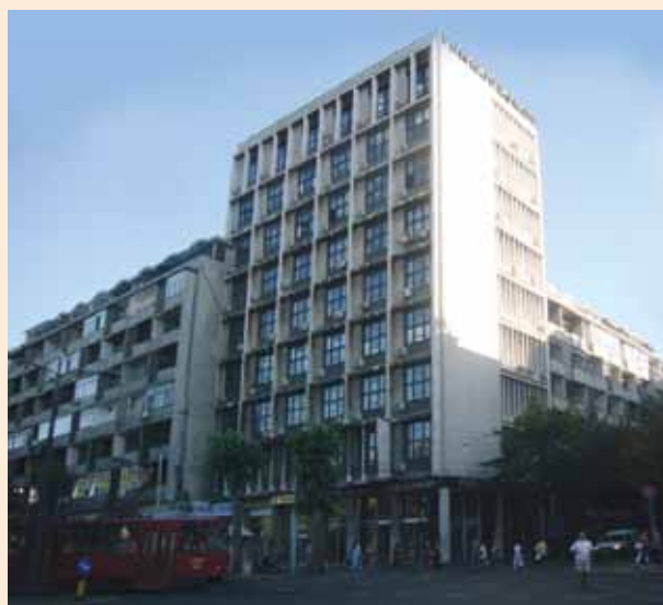
Сл. 9. М. Маринковић, Ђ. Грујичић, Љ. Драгић, Стамбено-пословни блок, угао Булевар краља Александра и Ресавске, 1953. Fig. 9. М. Marinković, Đ. Grujičić, Lj. Dragić, Mixed Residential/ Commercial Block, Corner of Kralja Aleksandra Boulevard and Resavska street, 1953.
