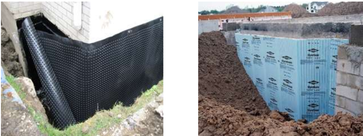
Slika 8. a. Gumirana hidroizolaciona membrana; b. Primer termičke izolacije Figure 8. a. Waterproofing rubberized membrane; b. Thermal insulation example
