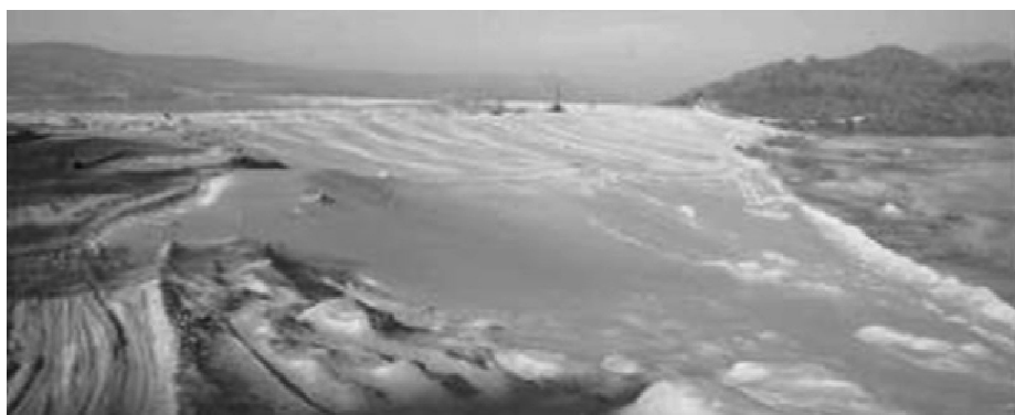
Sl. 3. Brana 2 kriveljskog flotacijskog jalovišta (2011)
