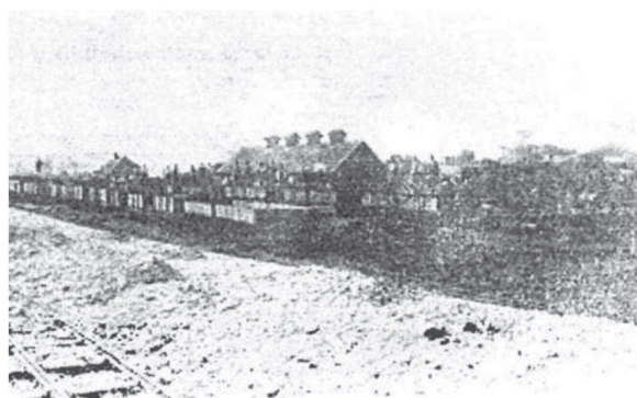
Слика 5, Уштоварна станица код Вујашевца Figure 5, Loading station near Vujaševac
