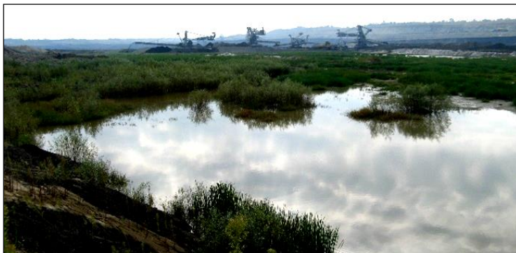
Slika 4 - Obodi zone mulja u nožici radne kosine UO PK TZP prekriveni samoniklim rogozom i topolom, visine preko 3.00 m (D. Božić)
