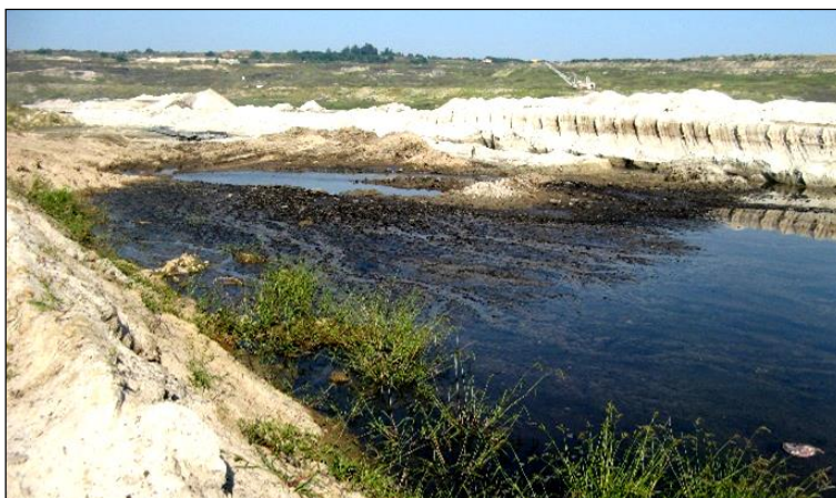
Slika 6 - Detalj istiskivanja mulja peskom (D. Božić)
