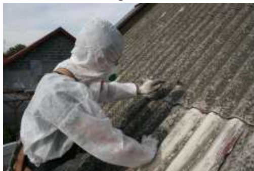
Slika 1 - Rad s azbestom u kontrolisanim uslovima (Izvor: http://gminadobre.pl/wnioski--azbest )
