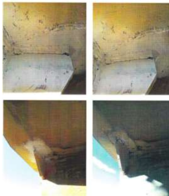
Slika 7 - Indikacije na mjernom mjestu broj 3 SRs 402 - interni broj 5
