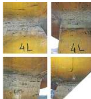
Slika 6 - Indikacije na mjernom mjestu broj 4 SRs 402 - interni broj 4
