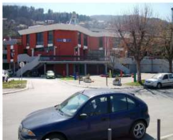
Слика 3 - Лево: перспектива предела око железничке станице Крчагово према идеји Р. Илић, десно: реализована железничка станица у Ужицу (1983) према пројекту С. Мандића
