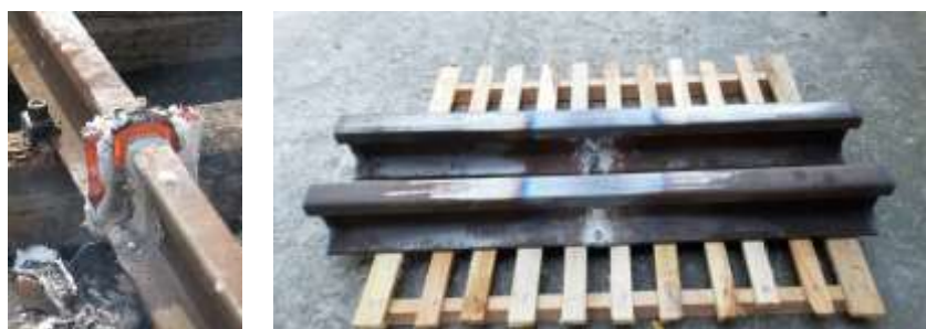
Slika 8 - Izgled šina nakon aluminotermijskog zavarivanja
