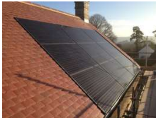
Slika 9 – STS integrisan u deo krovnog omotača
