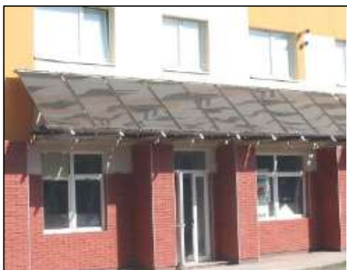
Slika 11 - Ravni zasenjivači sa integrisanim STS na kosoj nadstrešnici iznad vrata i prozora
