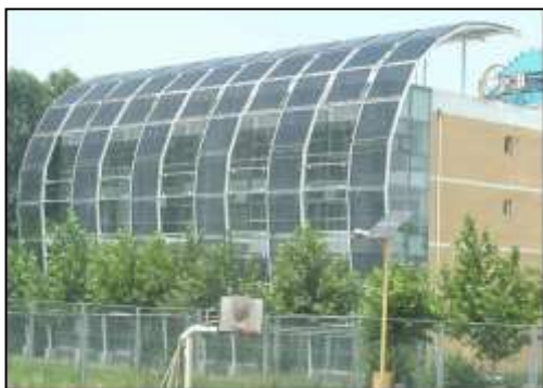
Slika 4 - Zakrivljena površina omotača zgrade formirana odgovarajućim brojem pločastih kolektora, AEE - Institut za održive tehnologije (AEE INTEC, Gleisdorf - Germany) [5]
