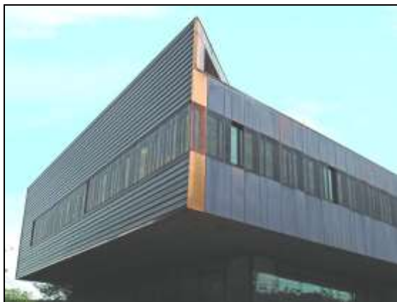
Slika 6 – Zgrada John W. Olver Transit centra u Grinfieldu, Masačusets, SAD [18]
