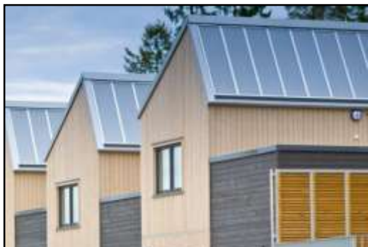
Slika 8 – STS integrisan u kosi krovni omotač zgrade
