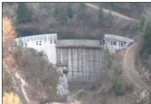
Slika 1 - Grafički prikaz deformacionog modela brane „Lipovica“ a) Kontrolna 2D mreža brane b) Nizvodno lice brane
