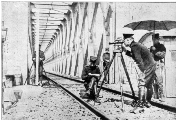
Slika 4 - Povezivanje mreže Preciznog nivelmana Kraljevine Srbije sa austrougarskim nivelmanom 1905. godine
