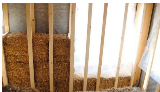
Slika 4 - Ugradnja bala slame kao izolacije kod drvene konstrukcije [10]
