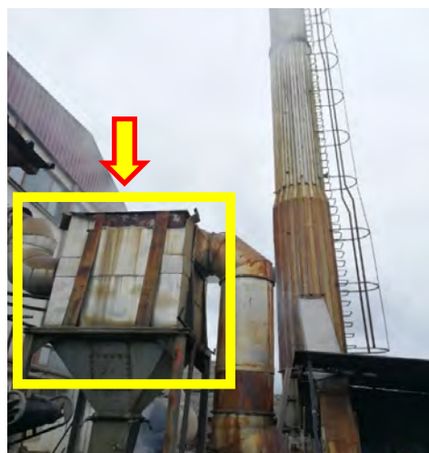
Slika 8: Multiciklonski otprašivač u okviru tekstilnog pogona [7]
