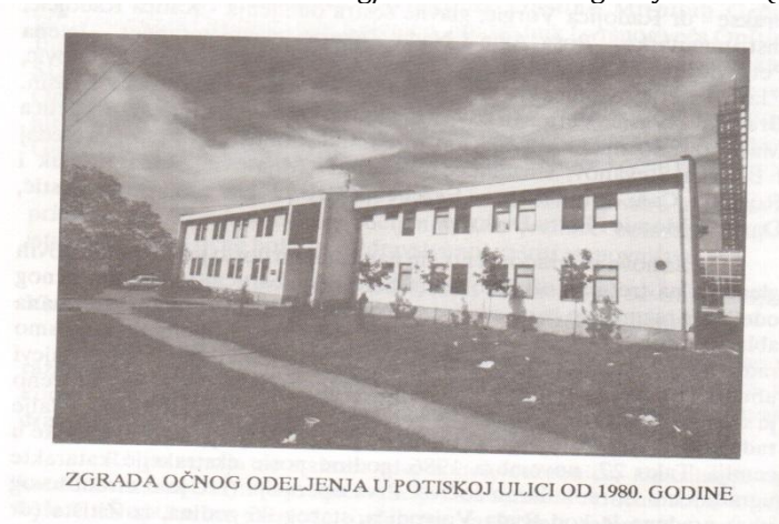
Slika br. 1 - montažna zgrada očnog odeljenja (1980. godina) Picture No.1-Prefabricated building/Modular building - Eye Ward (1980).
