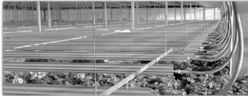
Sl. 4. Cevna mreža za zagrevanje u zaštićenom prostoru (SAD) Fig. 4. Tube net into greenhouse (USA)
