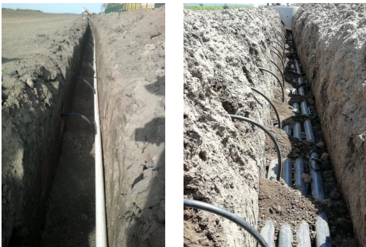
Sl. 6 Položaj razvodnih i kolektorskih (ispirajućih) cevi u odnosu na laterale Fig. 6 Position of distribution and collector (flushing) manifold with respect to laterals
