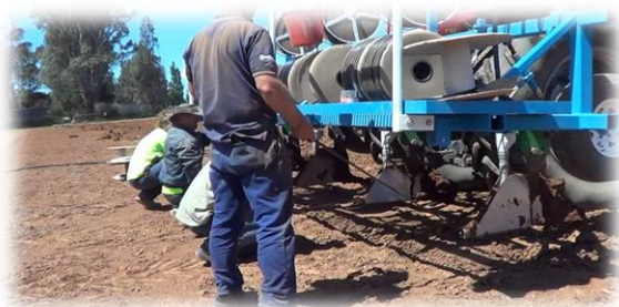
Sl. 1 Postavljanje (ukopavanje) laterala u zemljište Fig. 1 Placing (burial) laterals in the soil
