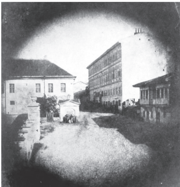
Слика 4. Старо здање
