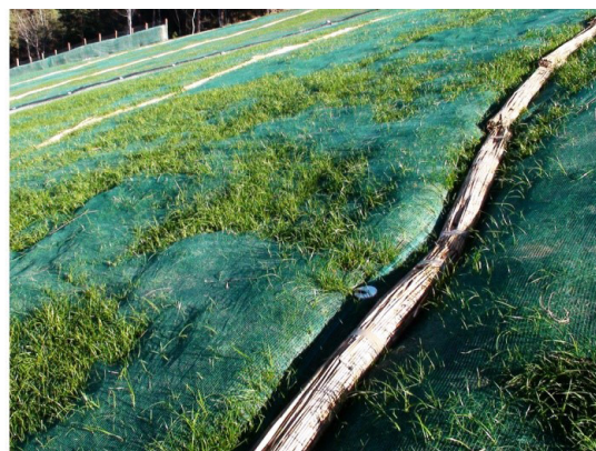
Слика 10 Контурни стабилизатори (баријере) за контролу брзог површинског отицаја (ски-стаза „Коњарник 1“, јуни 2009)
