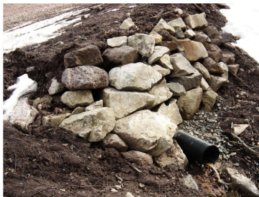
Слика 8 Стабилизационо-дренажна конструкција (излив; ски-стаза „Коњарник 1“, Октобар 2008)
