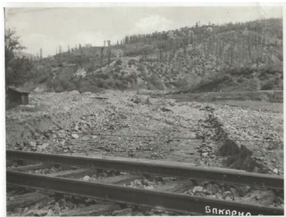
Слика 1. Трајна заштита железничких пруга од бујичних токова тежак је проблем, нарочито у Грделичкој клисури.
