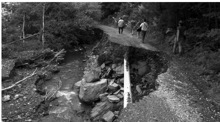
Слика 11. Типично оштећење локалних путева уз обалу реке Чађавице какво се може уочити на већини уских речних долина у сливу Ликодре
