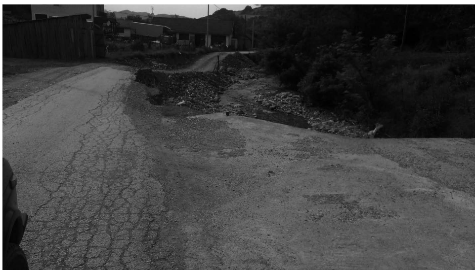
Слика 15. Прелаз на неуређеном делу Богоштице са недовољном пропусном моћи који је изазвао изливање и ерозију корита
