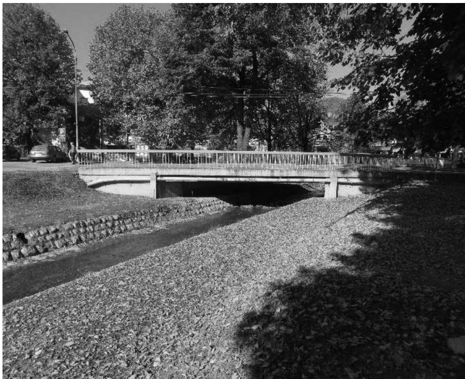
Слика 14. Мост на Богоштици са недовољном пропусном моћи Figure 14. Bridge on Bogoshtica with insufficient flow capacity
