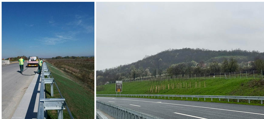
Слика 10. Примена хидросетве на аутопуту Милош Велики код искључења за Обреновац (лево) и на потезу Прелјина-Пожега, деоница 3 (десно) (фото Т. Мандић)
