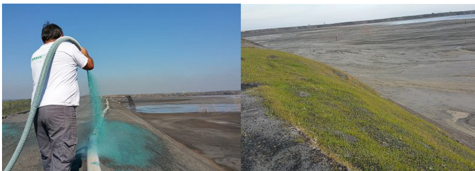
Слика 12. Примена хидросетве на депонију пепела у Обреновцу ( https://hidrosetva.rs/deponija-pepela-obrenovac/ ) Figure 12. Application of hydroseeding at the ash landfill in Obrenovac ( https://hidrosetva.rs/deponija-pepela-obrenovac/ )
