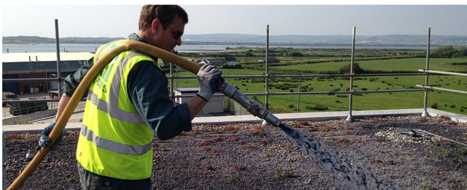
Слика 6. Примена хидросетве на зеленом крову центра за обуку Краљевских маринаца у Девону (Devon, UK) ( https://www.cdtshydroseeding.co.uk/green-roof-at-instow-devon/ )
