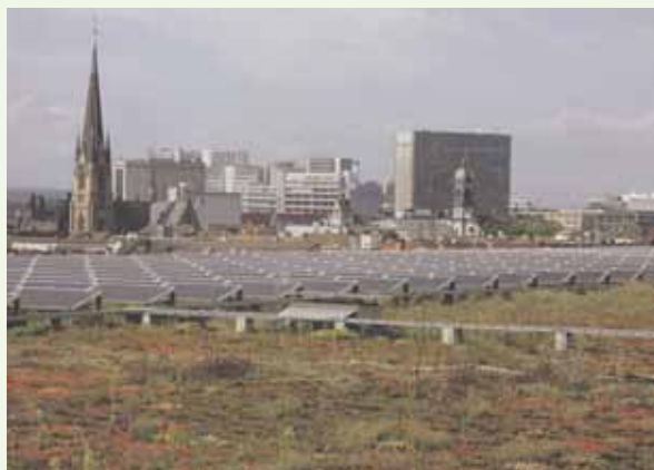
Сл. 1. Екстензивни кровни врт са фотонапонским модулима, Базел Fig. 1. Extensive roof garden with photovoltaic modules, Basel
