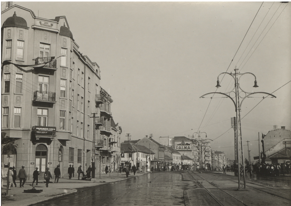
Сл. 5. Зграда Војина Стојановића, прва с лева, изглед око 1930. / Fig. 5. Building of Vojin Stojanović, first from the left, appearance around 1930
