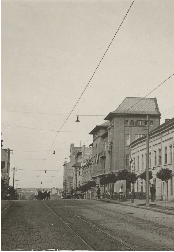
Сл. 6. Зграда Љубивоја Малетића, изглед ка Крунској, око 1930. Fig. 6. Building of Ljubivoje Maletić, façade towards Krunska Street, around 1930
