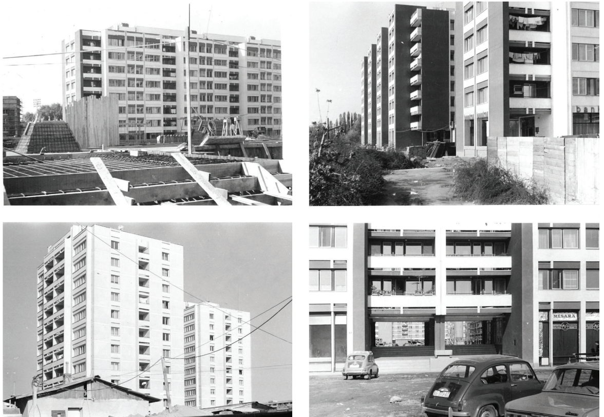
Слика 5. Стамбени блокови и куле у Блоку 2 током и након изградње, Нови Сад, 1972. / Figure 5. Residential blocks and towers in the Block 2 during and after construction, Novi Sad, 1972.
