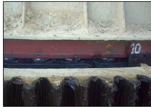
Slika 33. Vizuelna kontrola rasterećenja kotrljajnih tela radiaksijalnog ležaja
