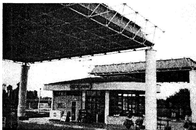
Slika 3. Pokrivna PRK za benzinsku pumpu "Agoprom" - Tetovo (2x208 = 416 m 2 ). Godina izvedbe 1994.
