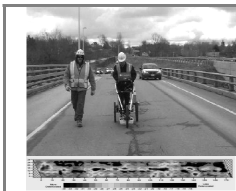
Slika 4: Ispitivanje ploče mosta radarom za ispitivanje zemljišta sa C-slikom
