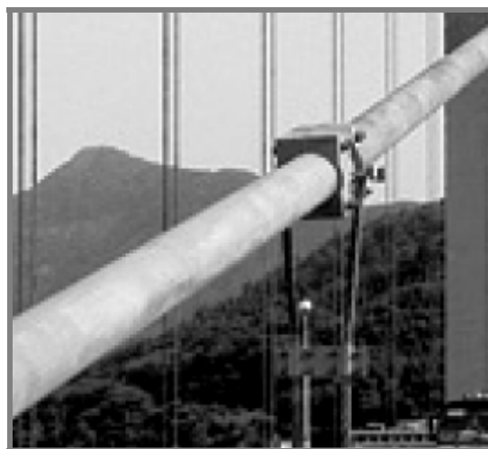
Slika 2: Neprekidno merenje deformacije elementa mosta [7]
