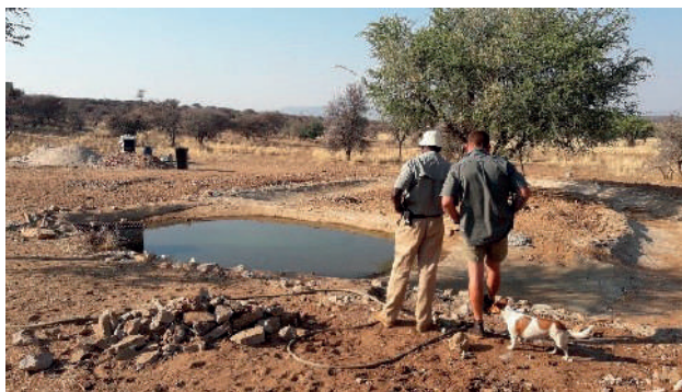
Слика 2. Поправљање појилишта (I) Figure 2. Repairing a waterhole (I)
