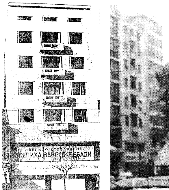
Slika 3. Zgrada na Terazijama br. 6 dograđena radi izravnjanja sa susednim (Arh. I. Popović)
