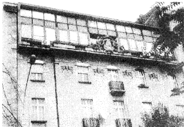
Slika 4. Stambena zgrada u Njegoševoj ulici 19, sa naglašenom dogradnjom iznad stilske fasade
