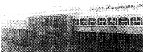
Slika 7. Dogradnja 2 sprata na zgradi Mašinskog fakulteta u Beogradu, usaglašena sa projektantom baznog objekta. Projekat dogradnje: arh. dr Žorž Popović, dr D. Buđevac i dr D. Bajić.
