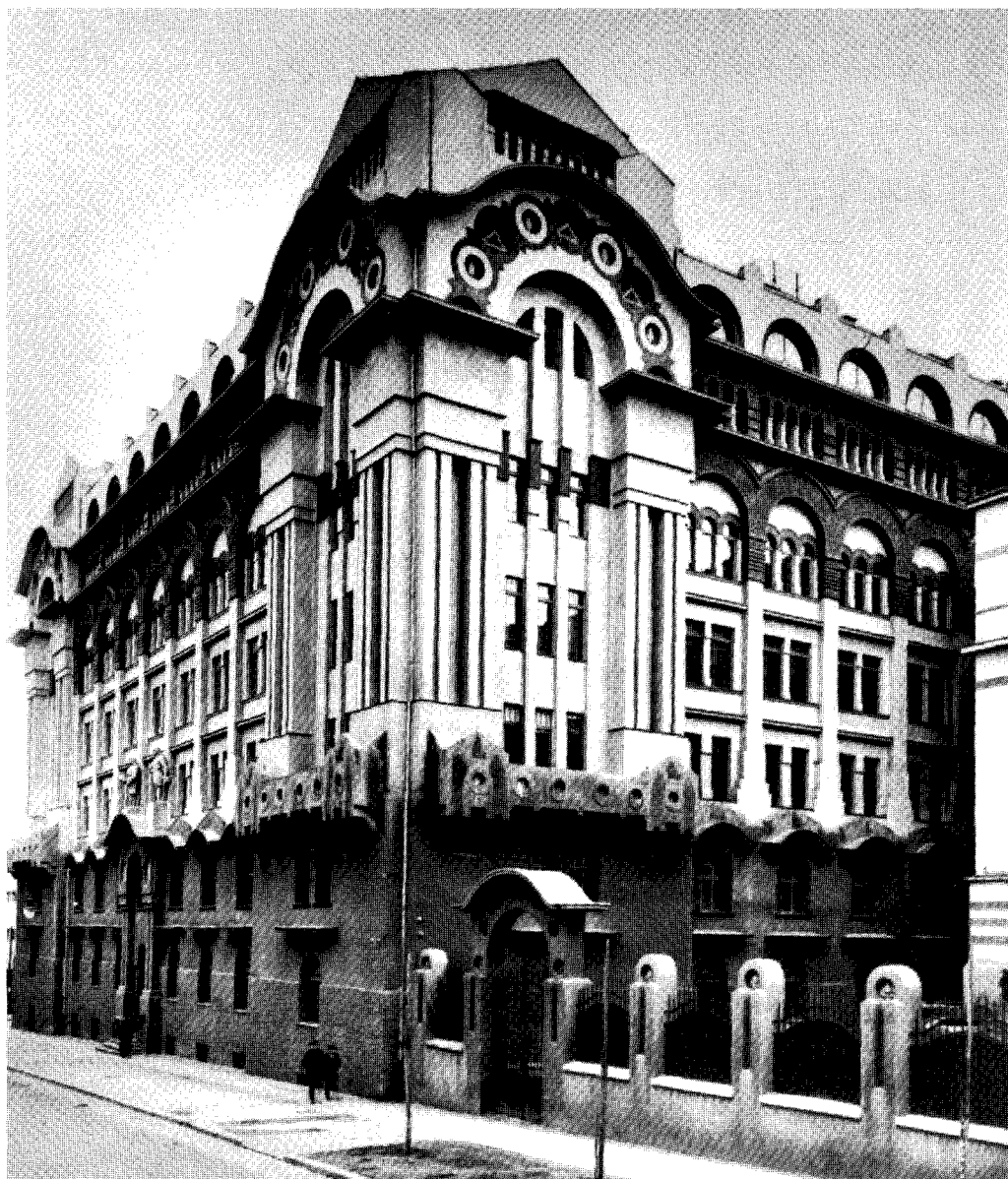
Сл. 1. Обишћи изглед зграде
