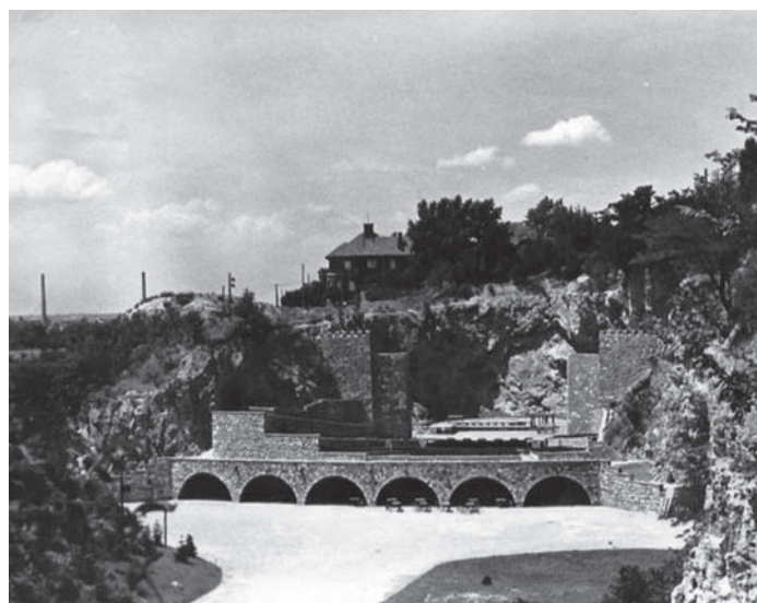
Сл. 4. Летња позорница, општи изглед (из Заоставштине Рајка Татића )
