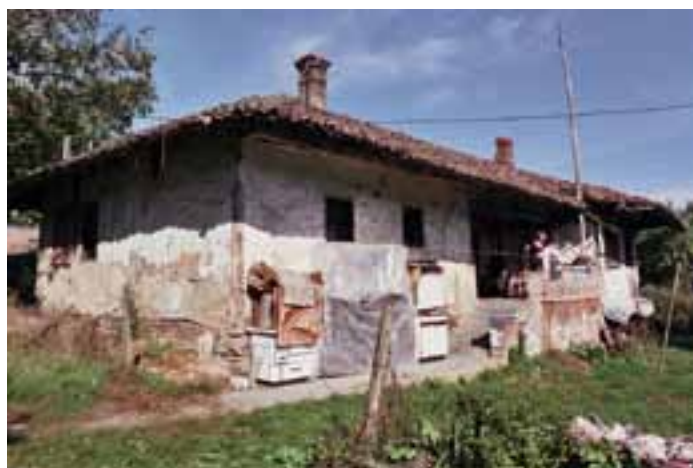
Сл. 19. Влајковићева кућа, садашње стање (С. Нејовновић)
