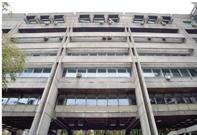
Сл. 6 / Детаљ фасаде објекта – изглед из Палмотићеве улице 2019. (фотографија С. Нејовановић)
