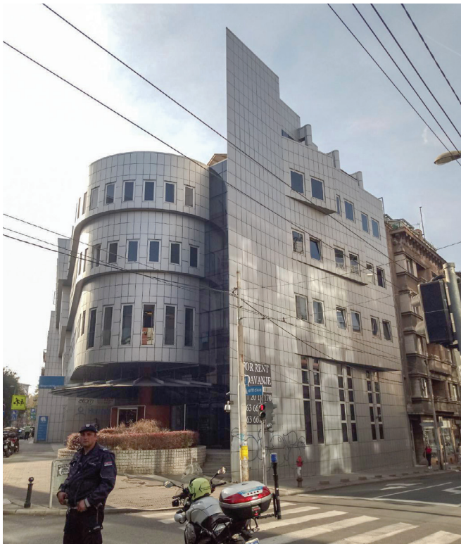
Сл. 5. Палаћа 'Зора', фасада на улици Макензијеве и Улице кнегиње Зорке (фотографија: М. Микић)
