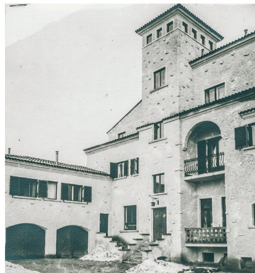
Сл. 15. Кућа Катарине Касидолац, Толстојева 19, изглед дворишне фасаде, око 1938. (ИАБ, ОГБ, ТД 29-18-1937)
