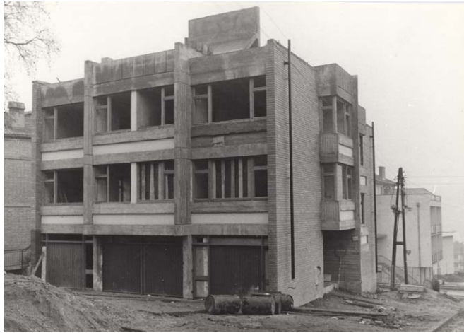
Сл. 4. Објекат на углу Какањске 2 и Гусларске улице у изградњи, око 1977. (фотографија А. Свјетковича)
