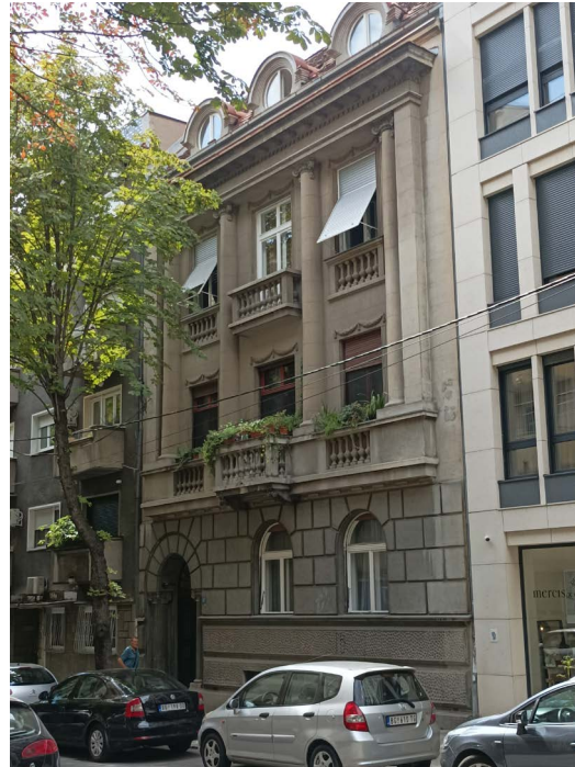
Сл. 6. Пројекат фасаде у Улици Проте Матеје 17, 1935. (извор: ИАБ, ФТД, ФХ-2-1935) и сјање на терену септембра 2024. (фотографија: А. Новаковић)
