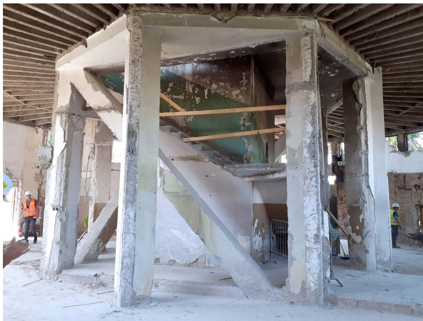
Сл. 4. Бетонски конструктивни склој средишњеј језгра у приземљу (фотографија: А. Шевић)
