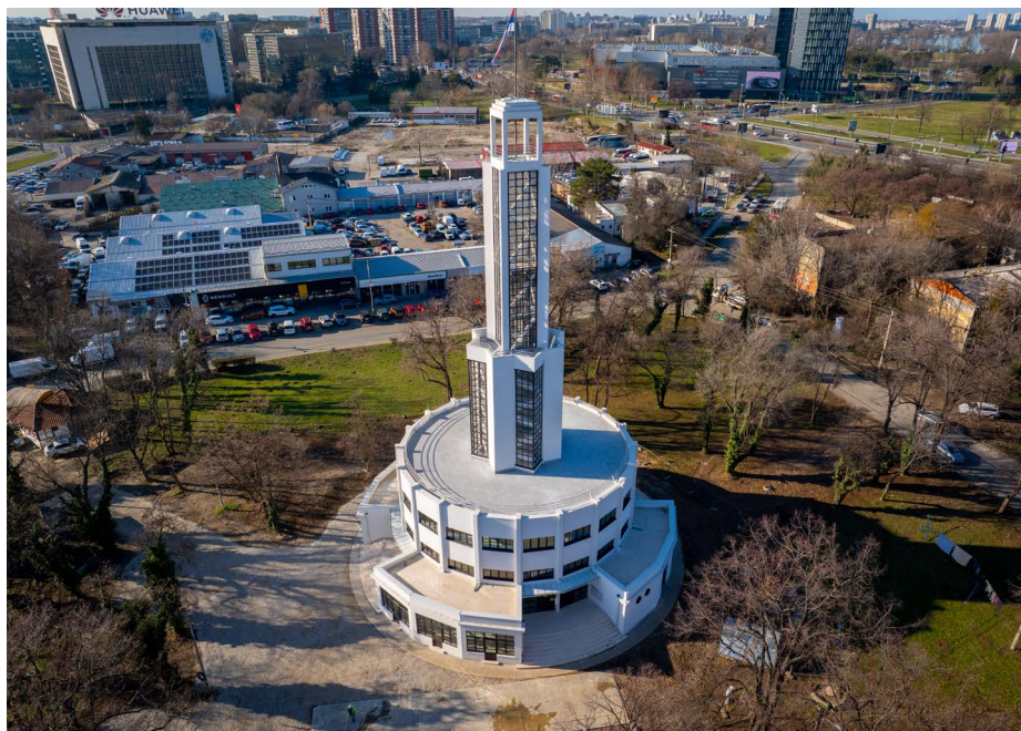
Сл. 11. Снимак Централне куле дроном по завршеној реконструкцији (фотографија: Кото д.о.о.)
