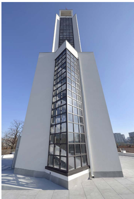
Сл. 9. Изглед реконструисаној подножја торња
