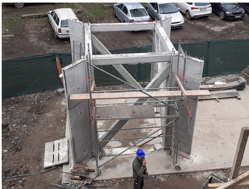
Сл. 5. Готови изливени армиранобетонски сегменти торња, 2023. (фотографија: А. Шивић)
