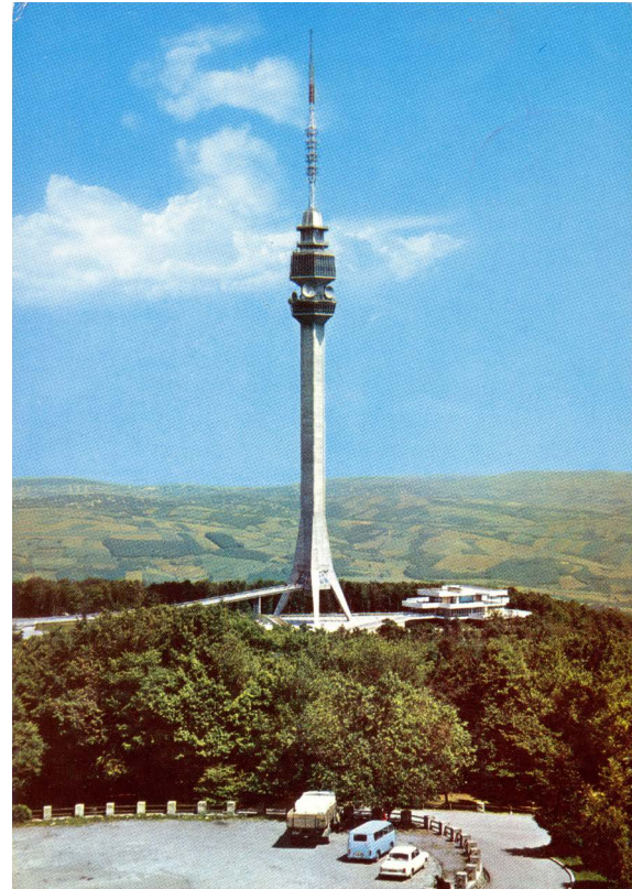
Сл. 5. Изглед Авалског торања (Колекција Милоша Јуришића)
