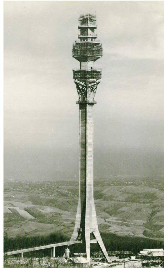
Сл. 2. Изградња Торња на Авали 1961. године (Колекција Милоша Јуришића)
