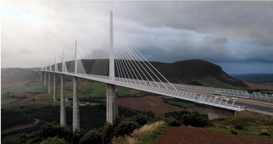
Figure 14. Viaduc de Millau (2015)
