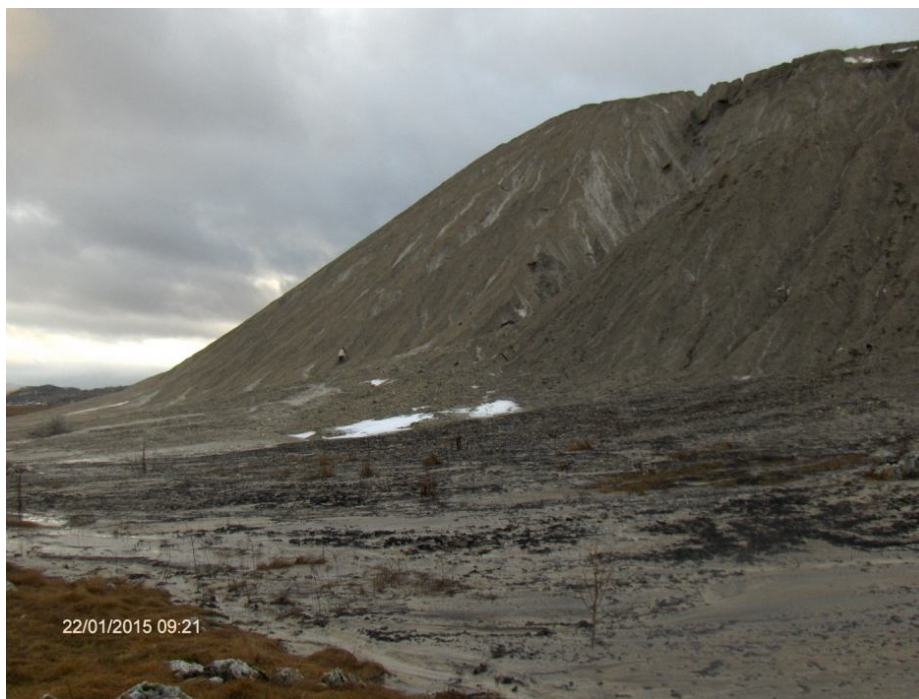
Sl. 3. Izgled kosine na vanjskom odlagalištu jalovine – Istočno odlagalište
