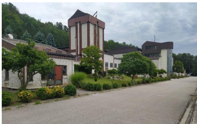
Слика 4. Постројење за прераду воде РВС „Рзав“
