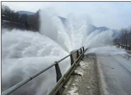
Слика 9. Мост Лучани истицање услед мразом изазваног пуцања засуна, и сам засун
