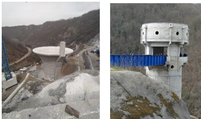
Слика 11. Изграђени објекти на брани „Сврачково“: Шахтни прелив и водозахватна кула
