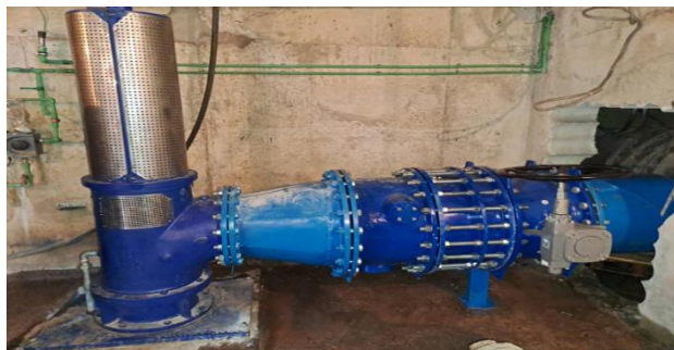
Слика 6. Спајање излаза инсталиране пумпе са колеторским цијевоводом. На слици су приказани неповратни, зауставни вентили и изграђен конус који редукује пречнике цијеви
