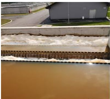
Слика 2. Индустрijske отпадне воде (металоперађивачка грана) у примарном таложнику
