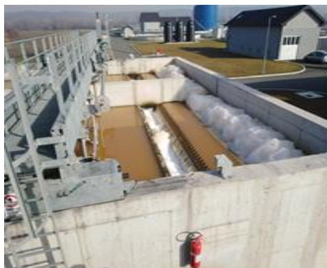
Слика 2. Индустрijske отпадне воде (металоперађивачка грана) у примарном таложнику
