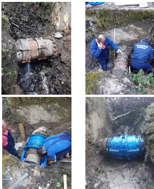
Слика 10. Санација оштећења цеви DN350 на споју цеви уз постојећу спојницу применом LONG EXTRA SPECIAL ADAPTER (Водовод Топола, октобар 2019)
