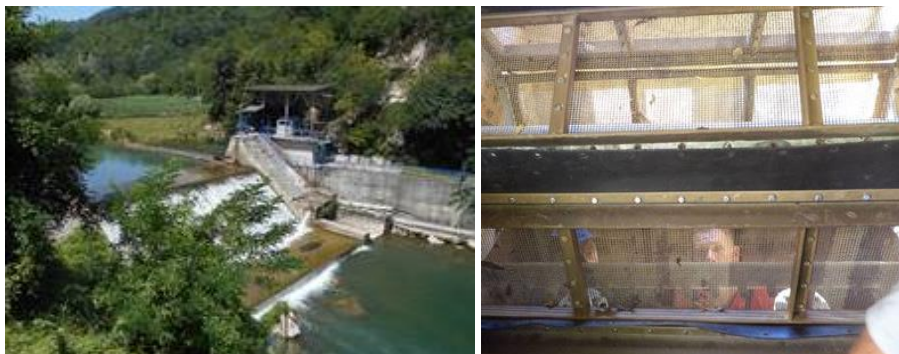
Слика 3. Шематски приказ и изглед привременог водозахвата „Шевељ“ са водозахватном грађевином, и једно од три ротационих сита за грубу филтрацију сирове воде
