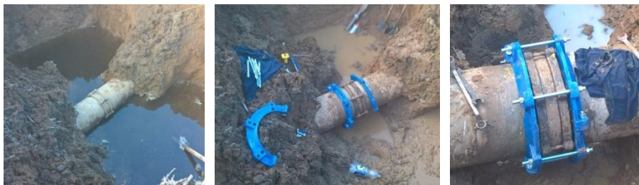
Слика 2. Отклањање цурења на постојећој спојници типа „Жибо“ на цевоводу називног пречника DN350 (Водовод Бела Црква, децембар 2016) Figure 2. Repairing leakage on existing „Gibault“ type joint on pipeline with nominal diameter DN350 (Bela Crkva Waterworks, December 2016)
