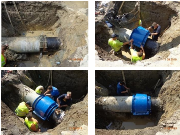
Слика 8. Санација оштећења цеви DN700 (Водовод Зрењанин, септембар 2019)
