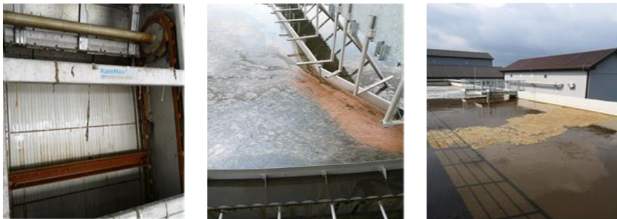
Слика 3. Грубе решетке, финални таложник и биоаерацијски базен након инцидентне ситуације
