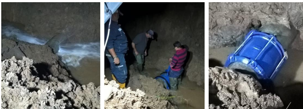
Слика 4. Санација пуцања цеви DN400 (Водовод Бела Црква, септембар 2017) Figure 4. Repairing DN400 pipe rupture (Bela Crkva Waterworks, September 2017)
