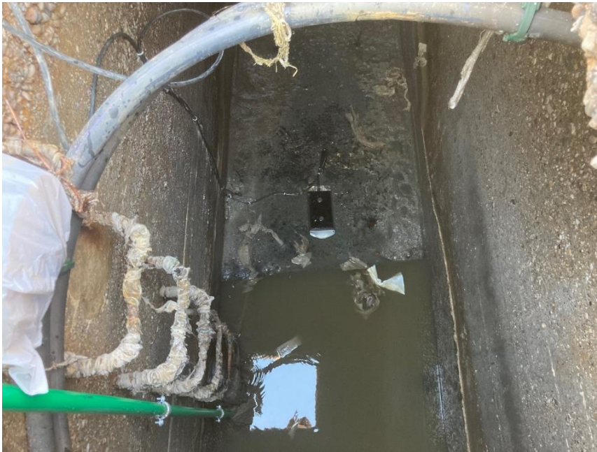
Слика 3. Мерно место на прагу унутар сабирне грађевине на потисима ЦС Стара и ЦС Нова, опремљено са мерилом дубине и редувантним мерилима брзине и дубине
