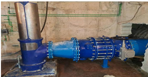
Слика 6. Спајање излаза инсталиране пумпе са колеторским цијевоводом. На слици су приказани неповратни, зауставни вентили и изграђен конус који редукује пречнике цијеве
