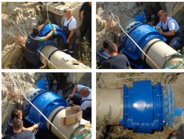
Слика 9. Санација оштећења цеви DN600 (Водовод Нови Сад, септембар 2016)
