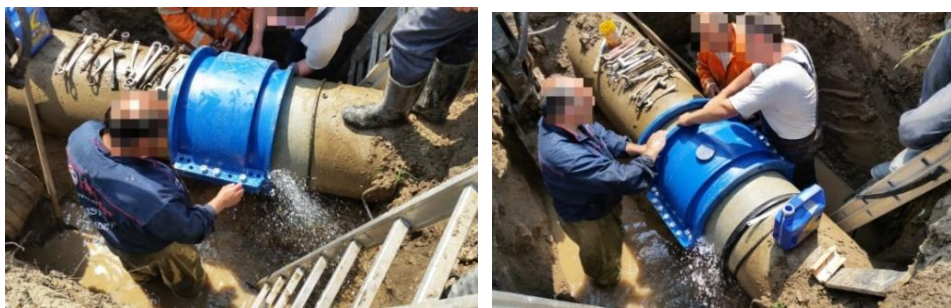
Слика 6. Санација оштећења цеви DN500 уз спојницу (Водовод Зајечар, мај 2015)
